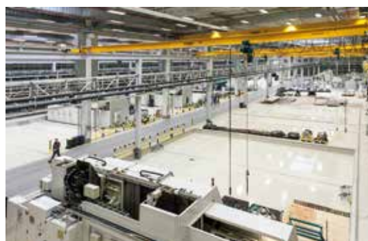
Neue Separatorenfabrik in Oelde
